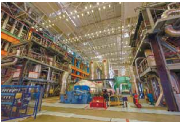
Фото: Калининская АЭС
